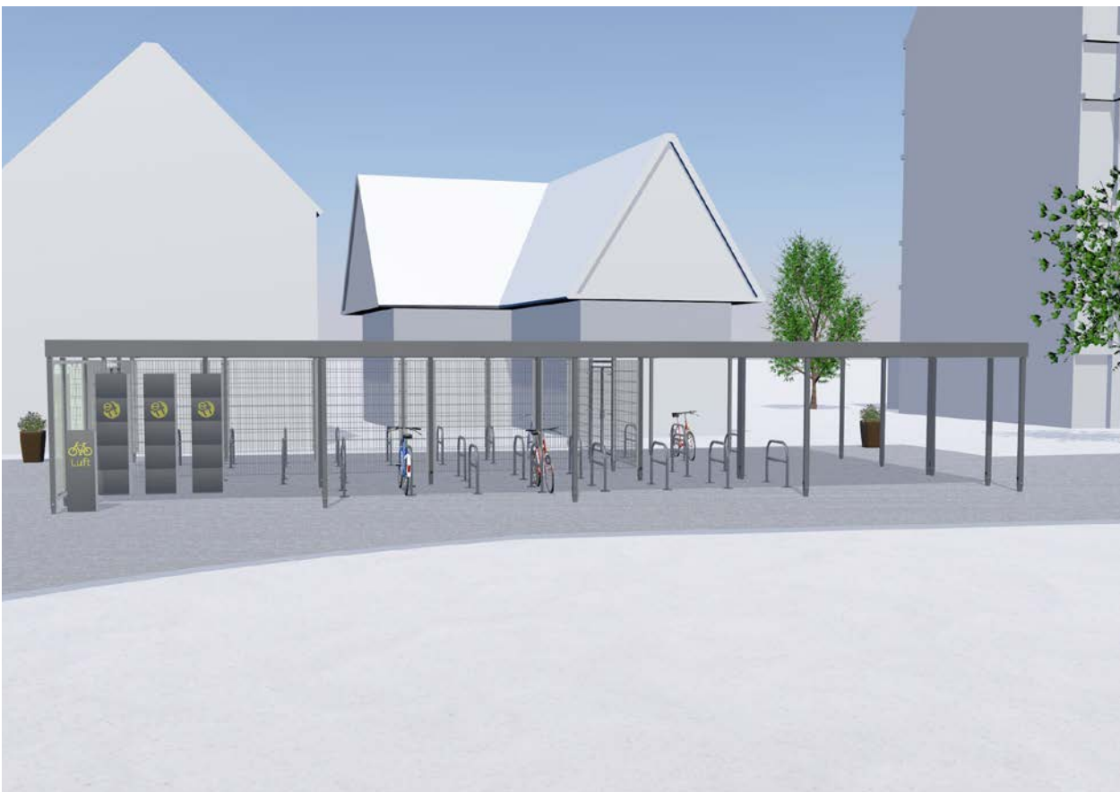
Überdachung PROTECT als Fahrradabstellanlage mit geschütztem Zugangsbereich und öffentlichem Abstellbereich, Ladeschränke für Pedelec-Akkus und Fahrradpumpenschrank
