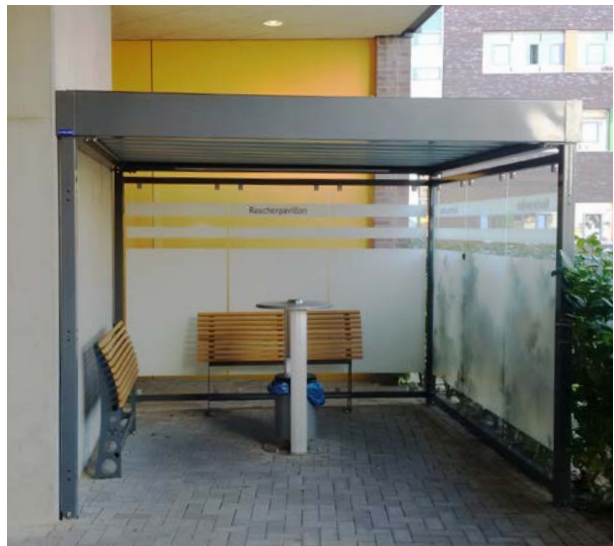
PROTECT mit Glasverkleidung als Raucherunterstand
