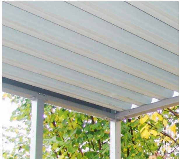
Trapezblech in Weiß als Dacheindeckung
